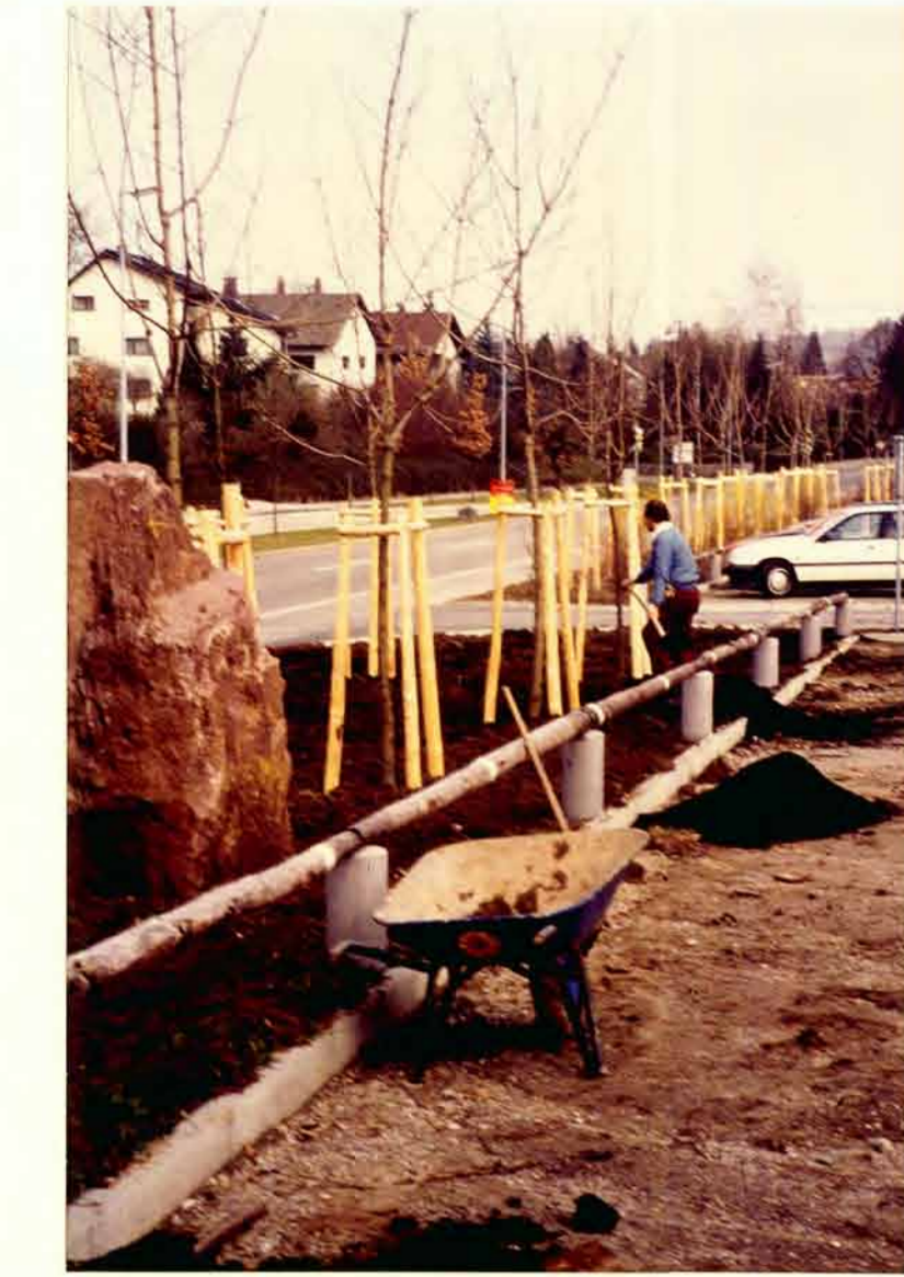
Pflanzarbeiten am Schwimmbad-Parkplatz
