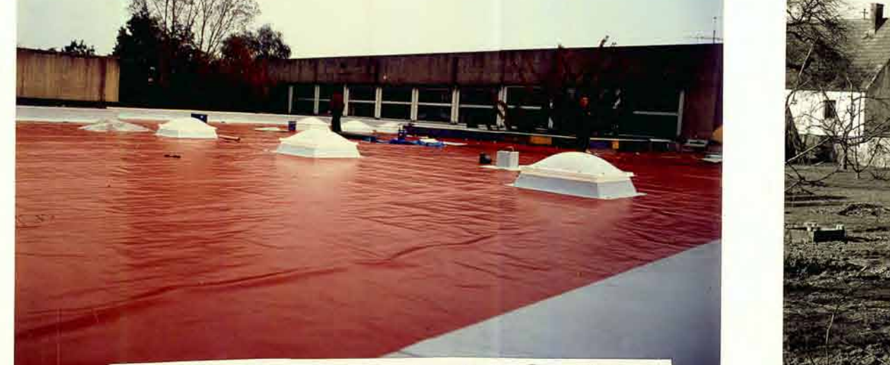
Flachdachsanieierung im Schulzentrum
