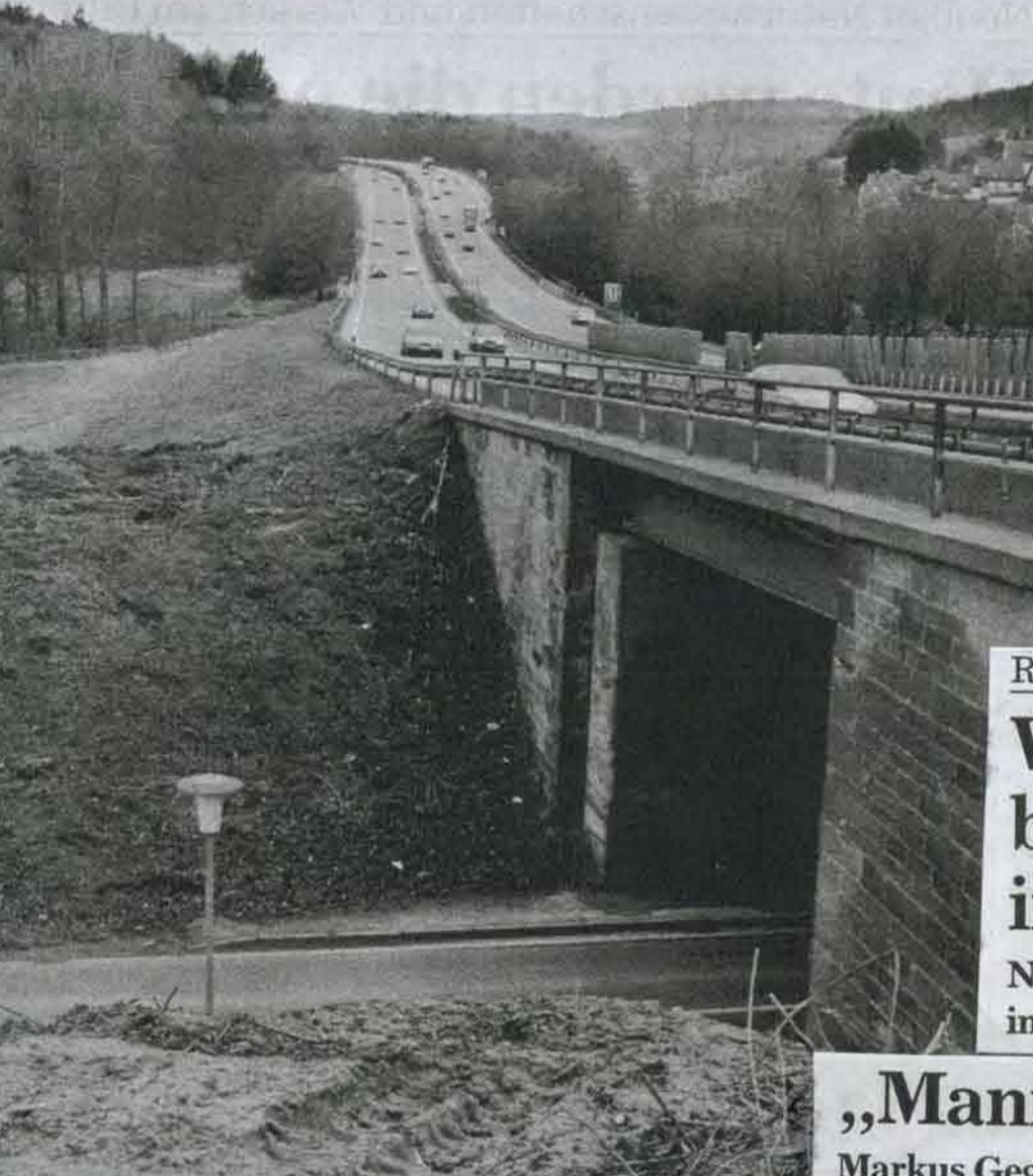
AUF DEM AUTOBAHNABSCHNITT BEI DARMSBACH werden Notahltestreifen angelegt. Dazu müssen auch die bestehenden Brücken verbreitert werden. Foto: Reichert
