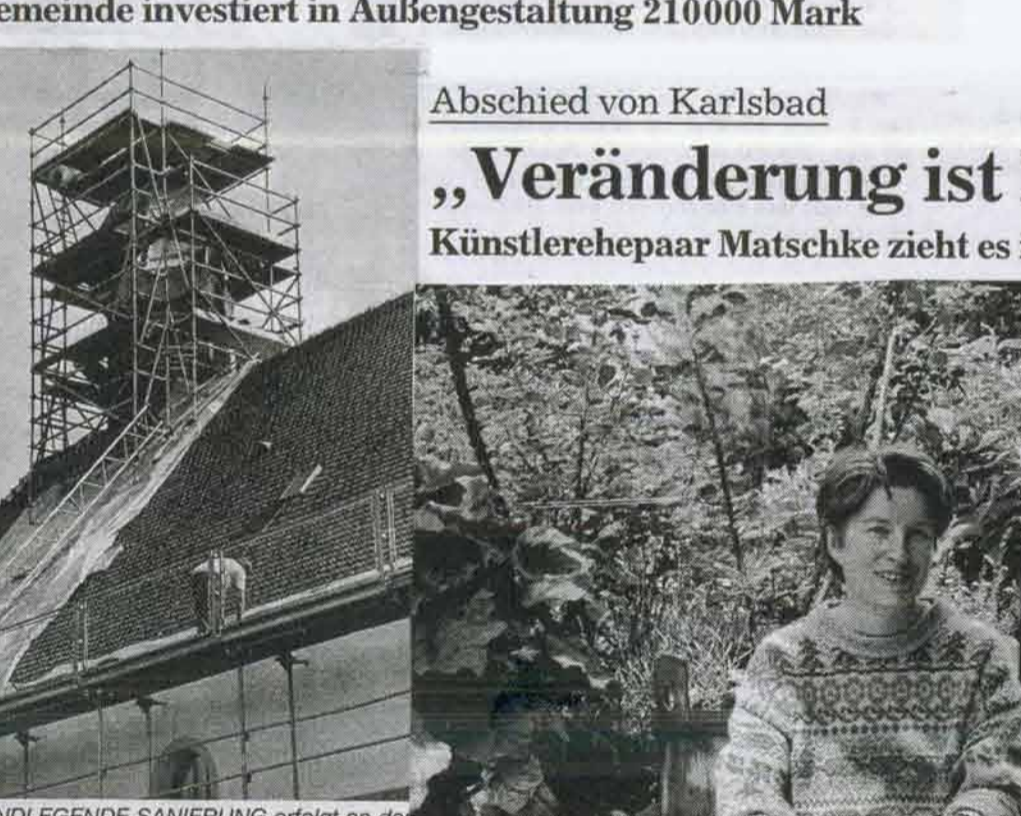
EINE GRUNDLEGENDE SANIERUNG erfolgt an der katholischen Langensteinbacher St.-Barbara-Kirche. Foto: AWR
