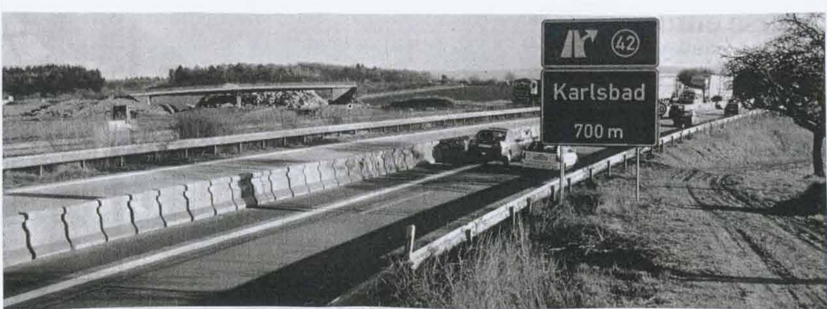
Ausbau der A8 bei Karlsbad. Die Baustelle auf der A 8 bei der Anschlussstelle Karlsbad. Zur Zeit sind die Fahrbahnen in beiden Richtungen verlegt und verengt. Von Baggern und Lastwagen werden große Erdmassen bewegt. Die Brücken stehen bereits.
