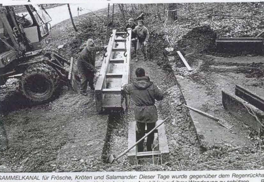
SAMMELKANAL für Frösche, Kröten und Salamander: Dieser Tage wurde gegenüber dem Regenklärteich ein Bootsabtrieb ein Beton-U eingebaut, um Antrieben auf einer Weisung zu schützen. Bp
