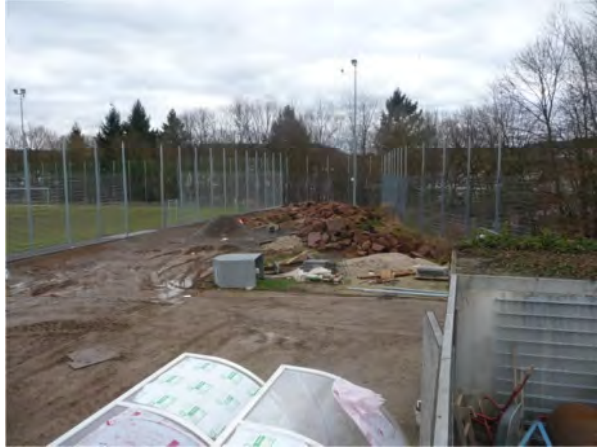
Verkürzter Rasenplatz, Bestandsumbau
