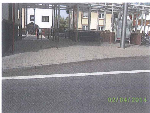
Bild 7: Absenkung des Bordsteins am Bahnsteig, Eisenbahnstraße in Richtung Schranke
