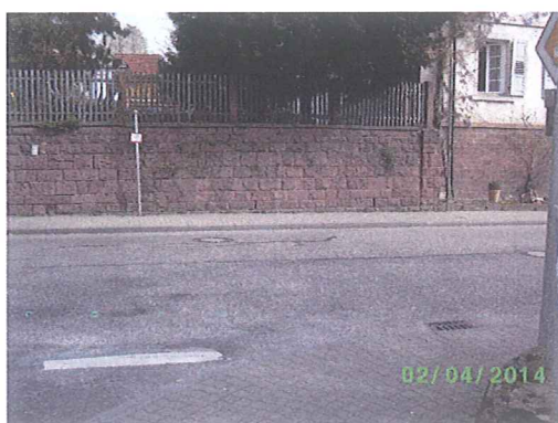
Bild 11: Absenkung Ettlinger Straße in Nähe zum „Schneckengässle“
