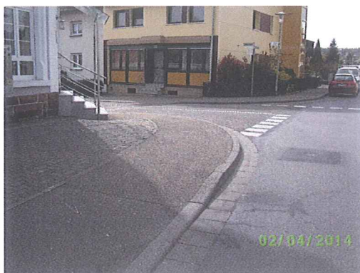
Bild 9: Absenkung des Bordsteins in der Eisenbahnstraße, gegenüber Bushaltestelle
