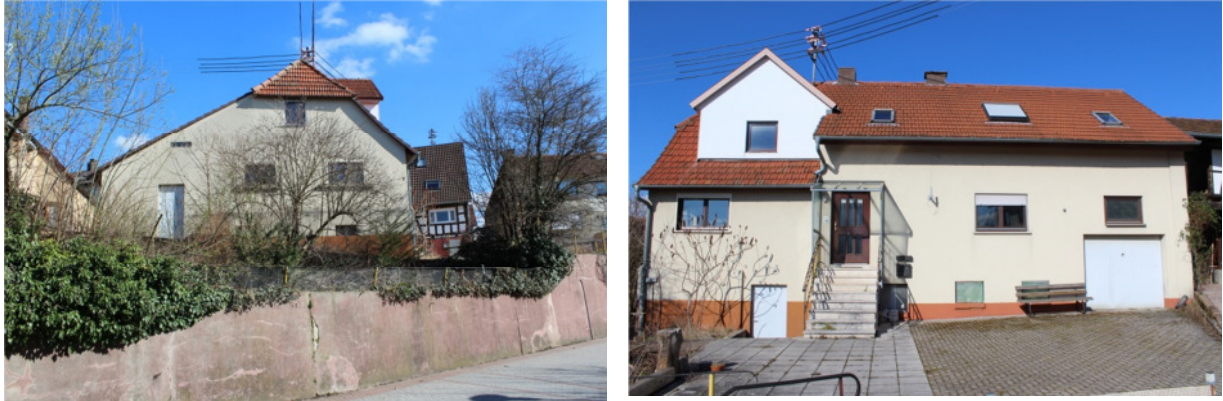
Speicherstraße 5. Das Gebäude soll evtl. abgerissen werden.
