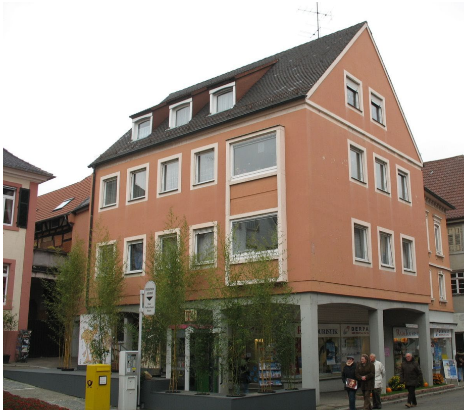
Friedrichstraße 11 Lahr - vorher
