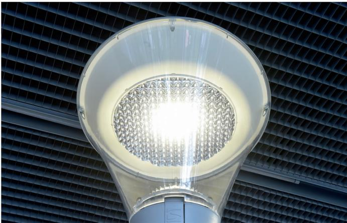
Die Beleuchtung von morgen ist besonders energieeffizient: Die einzelnen Laternen verfügen über LEDs, können individuell, bedarfsgerecht gesteuert und über ein Monitoring-System überwacht werden. Die Technik ermöglicht sogar eine „mitlaufende“ Beleuchtung: Das System registriert Fußgänger oder Radler und schaltet die Lampen vor ihnen vorausschauend an und hinter ihnen wieder ab.
