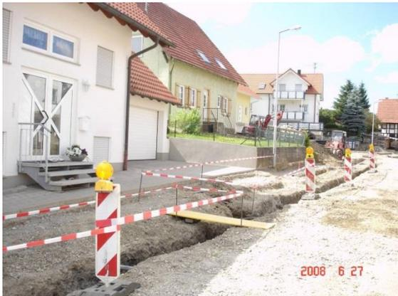
**Abbildung 39** Beispielbild Verlegung Wärmenetz im Bestand
