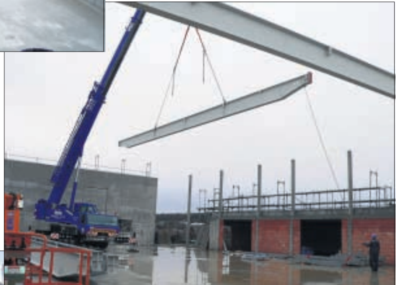
Imposanter Stahlträger beim Einbau
