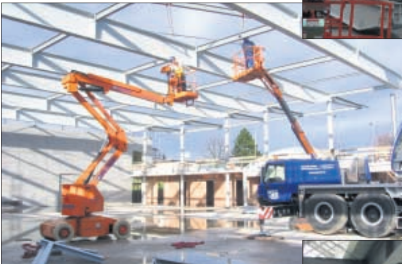
Die Deckenkonstruktion nimmt Gestalt an
