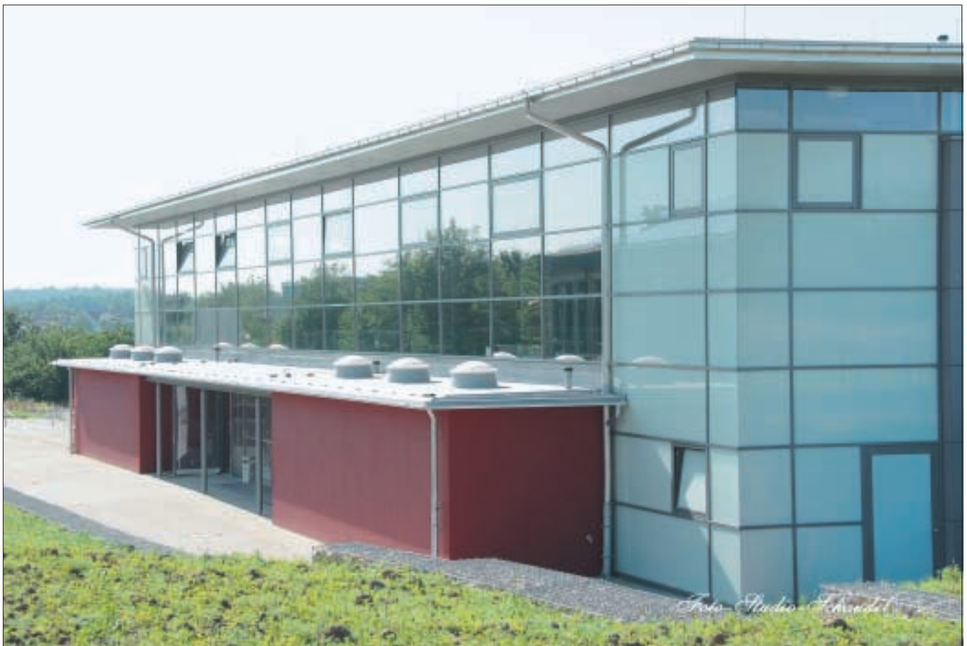
Blick auf die Nordfassade mit der sich auf der Halle spiegelnden Umgebung.
