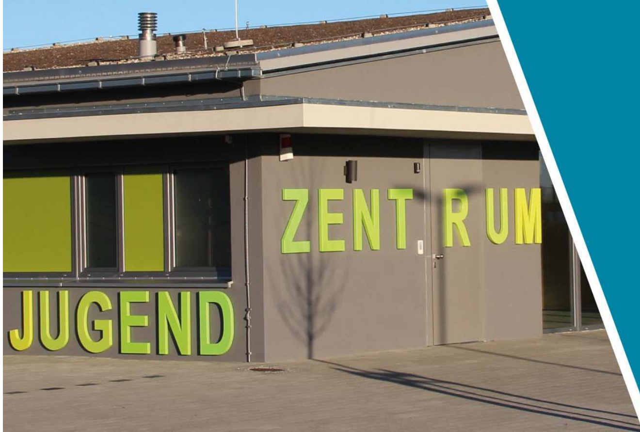
Neues Jugendzentrum in Langensteinbach
