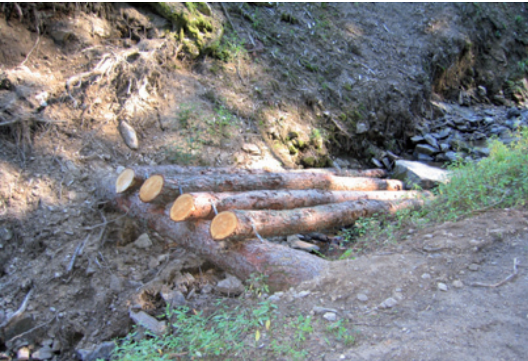
Abb. 31: Einfache Rechen im Wald zum Rückhalt von Ästen und Zweigen
