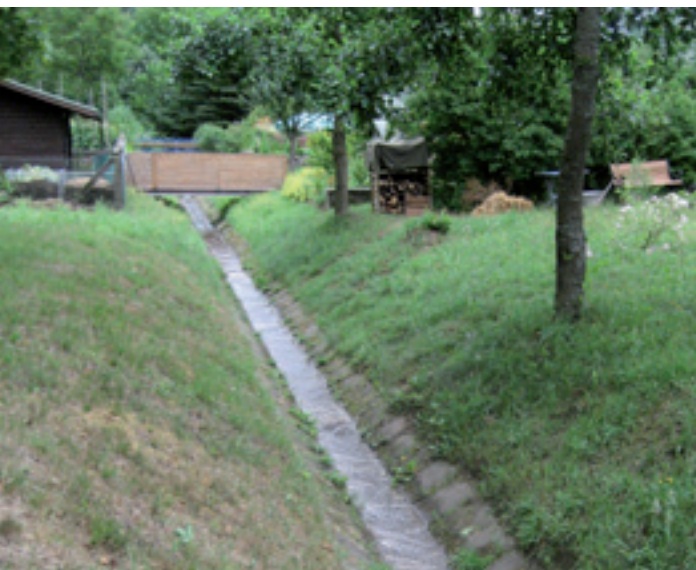
Abb. 15: Übergangshilfe und Einengung des Abflussquerschnitts
