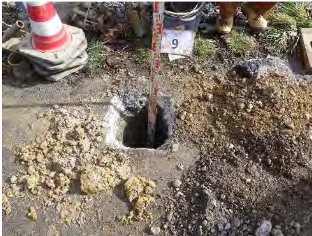
Foto 9: Vorschacht und Aushub bei RKS 9
