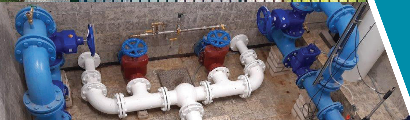
Neubau Hochbehälter Sallenjagen
