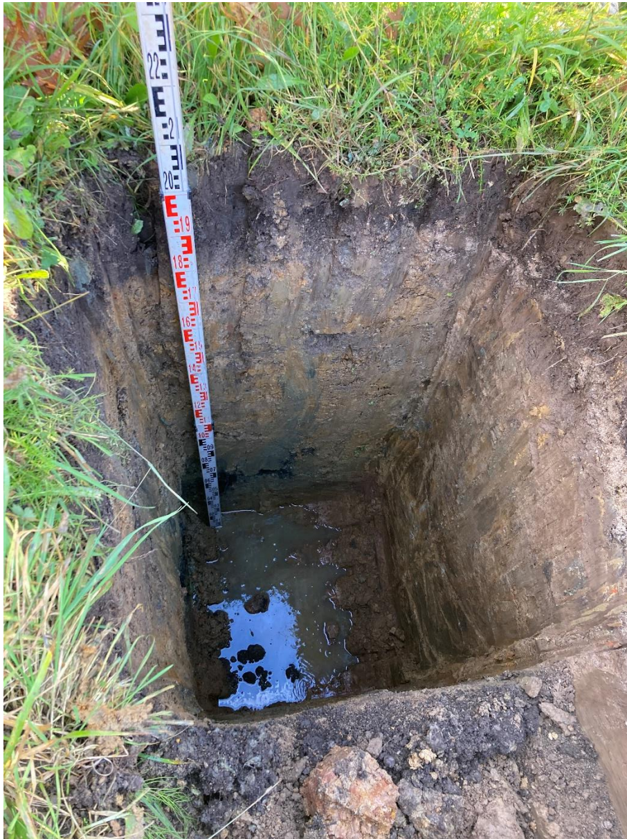
Bild 3: Friedhof Spielberg: Schurf im nordöstlichen Altgrabfeld (süddlich der Mauer) bis 2,1 m Tiefe mit seitlichem Wasserzutritt aus Altgrab (05.11.2025)
