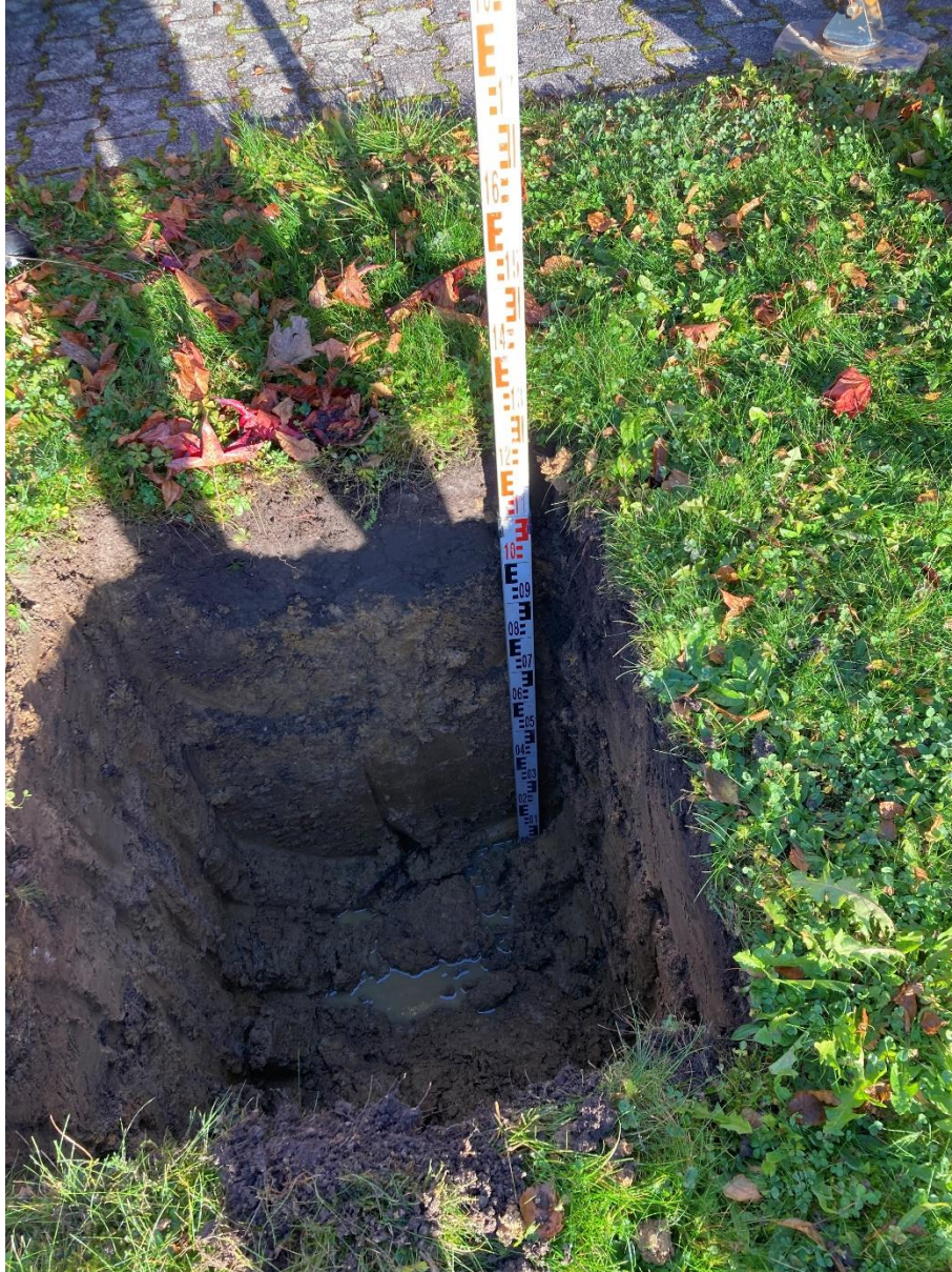
Bild 1: Friedhof Spielberg: Schurf im nordöstlichen Altgrabfeld (nördlich der Mauer) bis 1,3 m Tiefe im Altgrab mit Wasserzutritt (05.11.2025)
